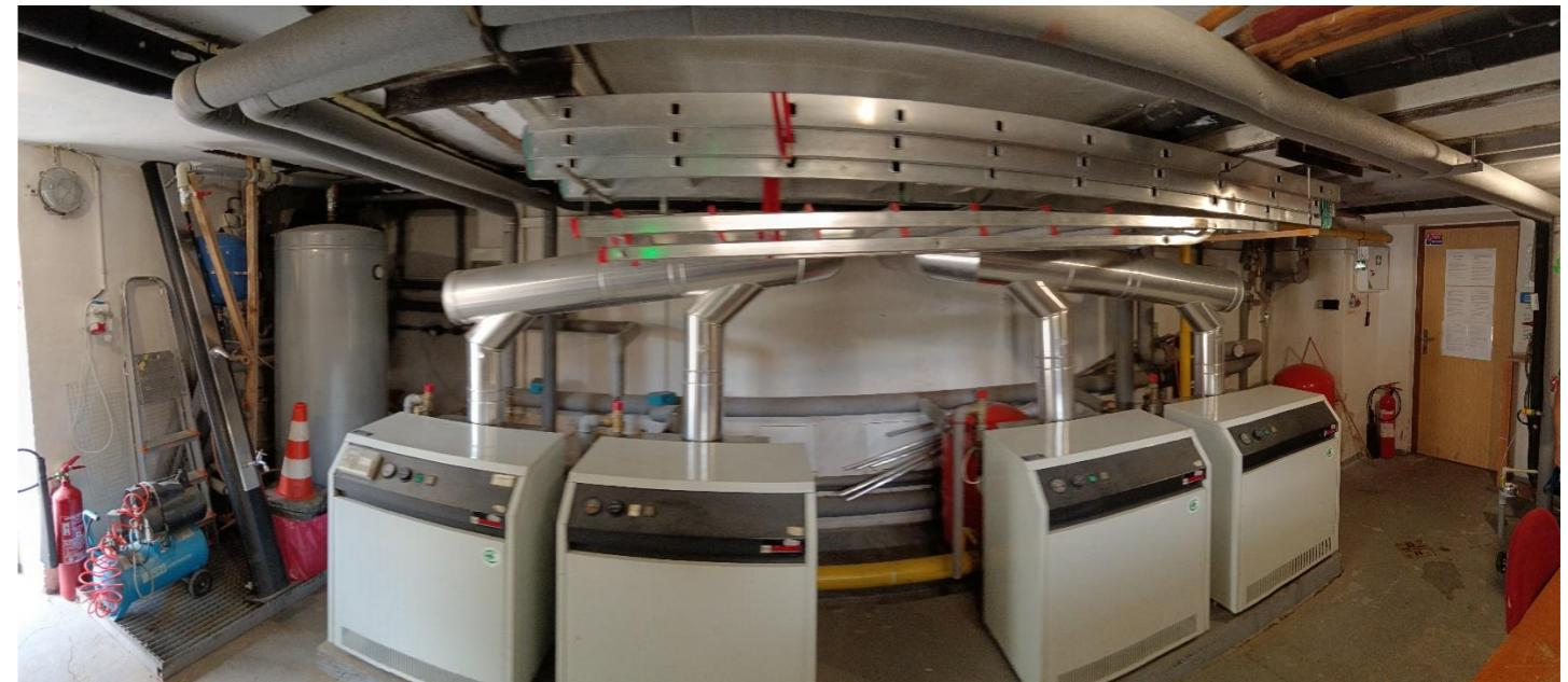
Jedná se o uzavřenou otopnou soustavu s nuceným oběhem. Potrubí topné vody z kotlů je přes HVDT napojeno na rozdělovač a sběrač, z kterého jsou vyvedeny celkem 3 topné větve:
